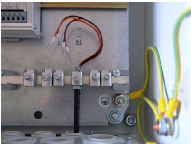
Abbildung 3: Aderendhülsen und Masseanschluss im Gehäuse
